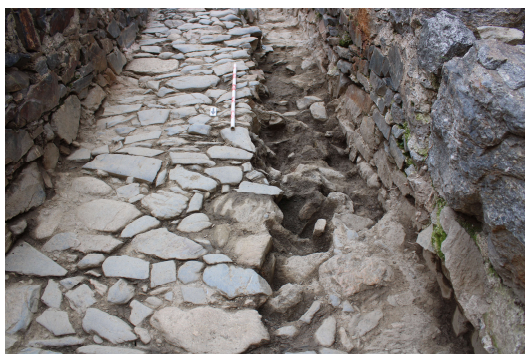
Restes del paviment original al pont dels Escalls que s'ha consolidat i conservat.
